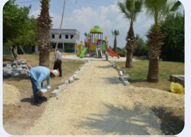
Adanalıoğlu Eylül Parkı yenileme çalışması yapıldı.
