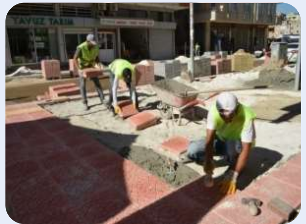
Asfalt Yama, Kaldırım Bordür, Kilit Taşı Döşeme ve Tamiri Çalışmaları
