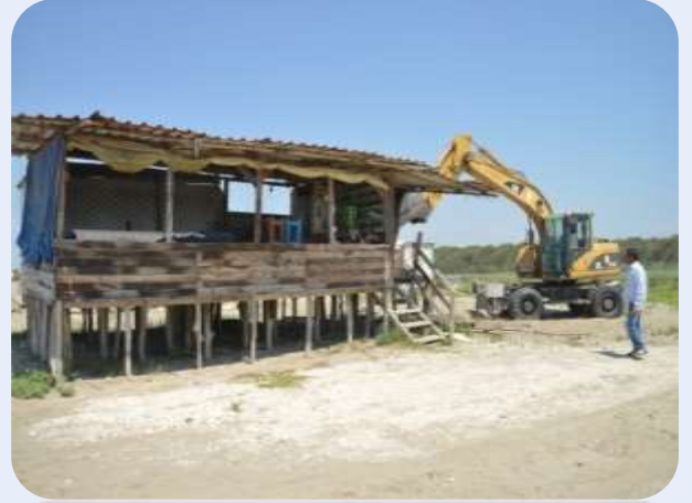
Metruk yapılar yıkıldı.
