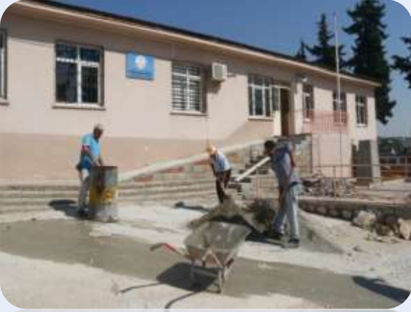
Okulların Bakım ve Onarımı yapıldı.
